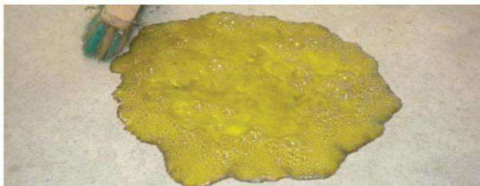
Pour les sols en béton ou en ciment, il sera nécessaire d'utiliser un nettoyant acide afin de **réduire l'alcalinité** de vos sols. Ceci renforcera l'adhérence de la peinture.
