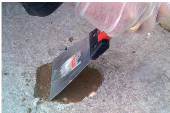
Puis, la surface de la zone réparée devra être **lissée** à l'aide d'une truelle, tout en laissant une légère surépaisseur par rapport au reste du sol. En séchant, le mortier risque en effet de descendre. Laissez sécher pendant une heure et lissez ensuite parfaitement le mortier. Enfin, vous pourrez lisser la surface à la taloche pour obtenir une surface totalement lisse.
